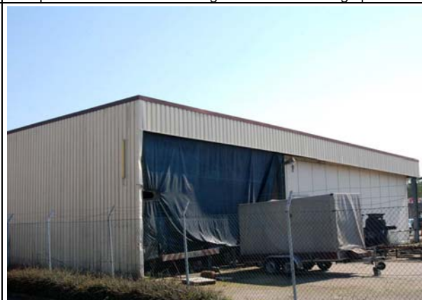
Lager und Werkstatthalle mit diversen Einflugmöglichkeiten, daher kein Ausschluss von Fledermausquartieren möglich
