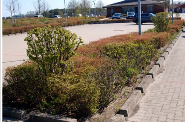
Ziergehölze und Bodendecker im Bereich der Stellplatzanlage, integrierte Versickerungsmulde
