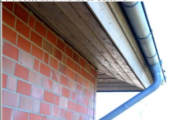
Geschlossene Abdichtung der Dachkonstruktion (ALDI)
